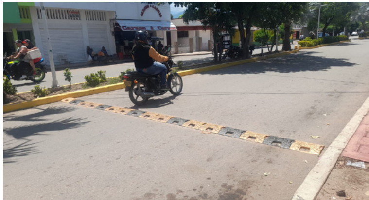
La Administración informó que la próxima semana comenzarán los trabajos relacionados con tres reductores.
