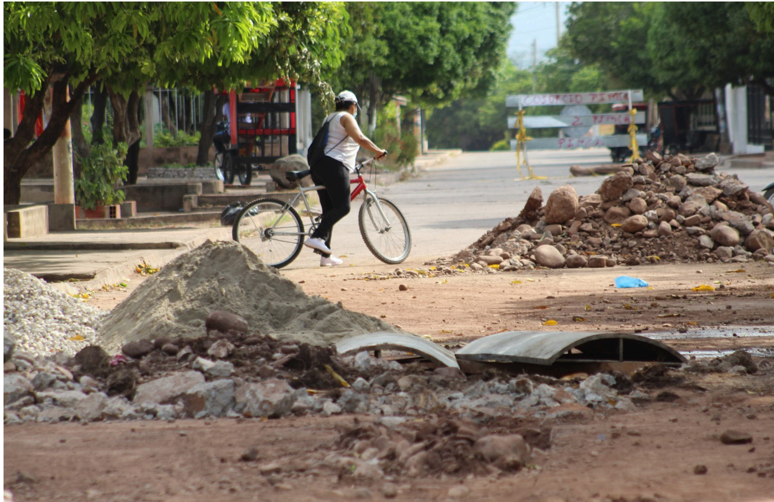
Cambio de redes de alcantarillado en el barrio Orozuz de Villanueva.
