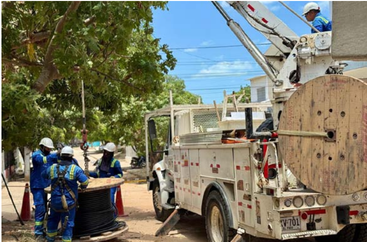
Esta nueva etapa contempla la instalación de 24 postes y la construcción de 1 kilómetro de red aérea.
