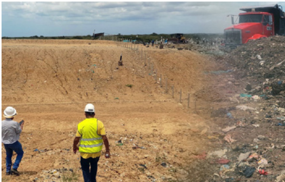
El uso de la celda transitoria entra dentro del proceso de cierre del relleno sanitario previsto para dos años.
