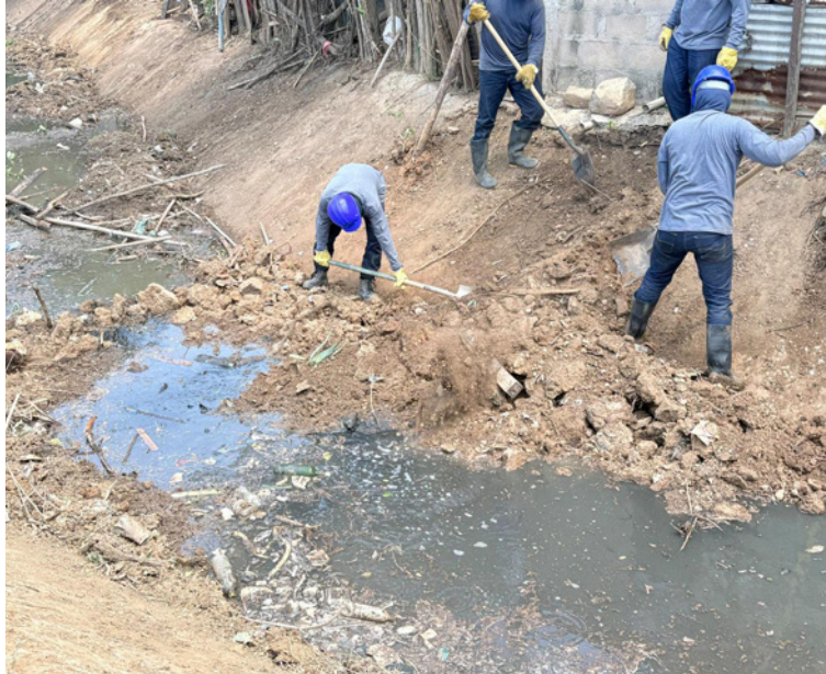
Los trabajos incluyeron limpieza, retiro de residuos sólidos, adecuación y mantenimiento de los puntos intervenidos.
