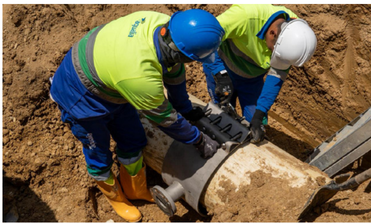
Corrección de fugas en la tubería.
