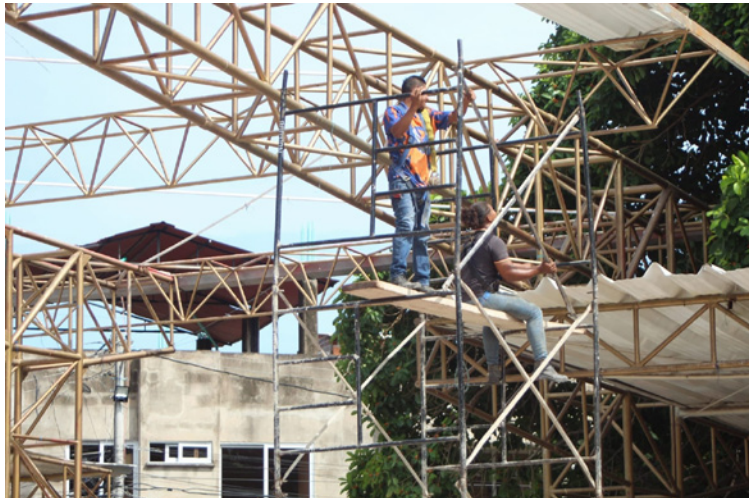
La intervención se concentra principalmente en la estructura alta de la tarima, que fue la que sufrió afectaciones.
