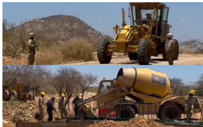
Los soldados adelantan la adecuación de terraplenes, pasos comunicantes y estructuras tipo box.
