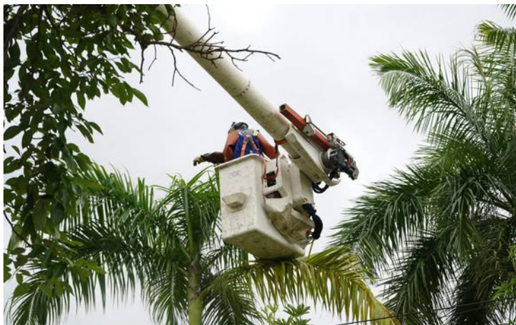
La empresa Air-e agradece a los usuarios, su amable comprensión durante la ejecución de los trabajos.
