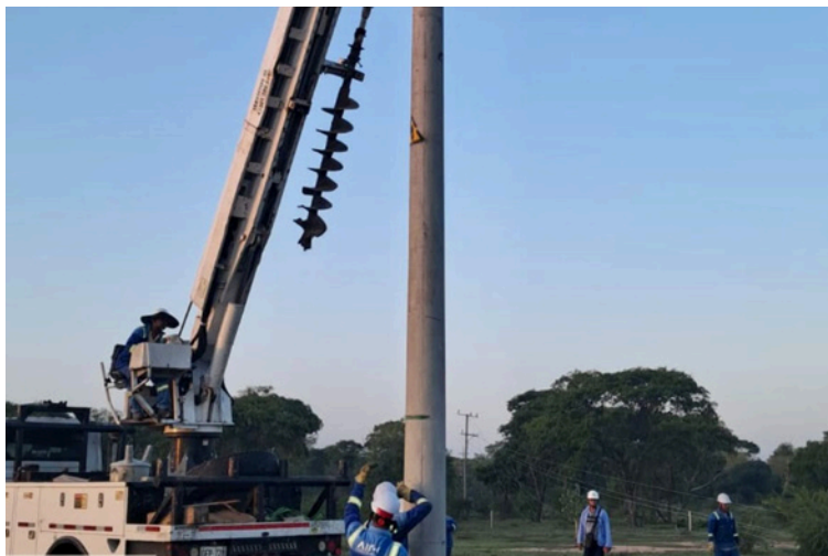
Las labores buscan avanzar en la recuperación de la infraestructura dañada y restablecer la prestación del servicio.
