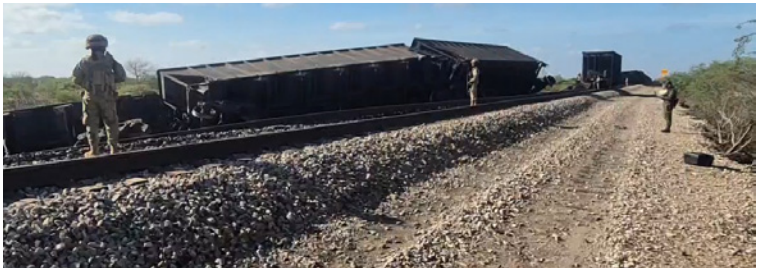
El ataque afectó un vagón que se movilizaba vacío en dirección sur y ocasionó daños materiales.
