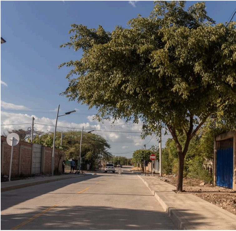
Explicó el alcalde Berardinelli que la obra mejora la movilidad, la seguridad y la calidad de vida en el sector.
