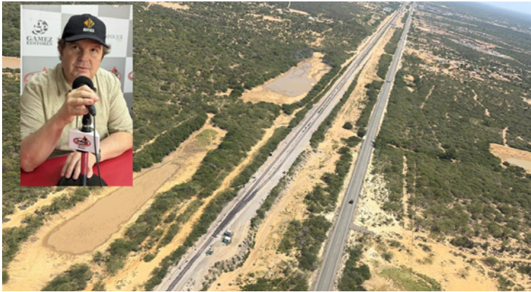
Entre las obras estratégicas se destaca la Conexión Alta Guajira, con inversión cercana a $295.000 millones.
