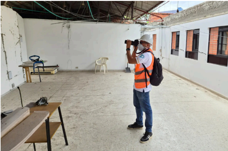
Docente de Uniguajira Iván Gómez Monroy evaluando las afectaciones del sismo.
