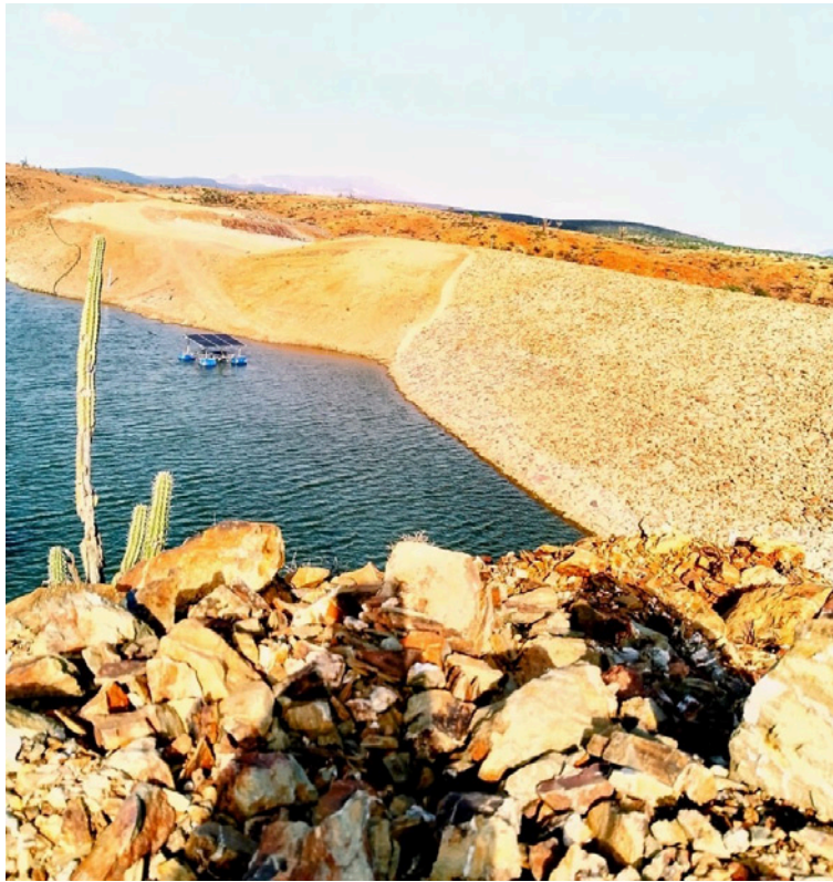
El proyecto cuenta con una planta potabilizadora para la extracción de agua del reservorio.
