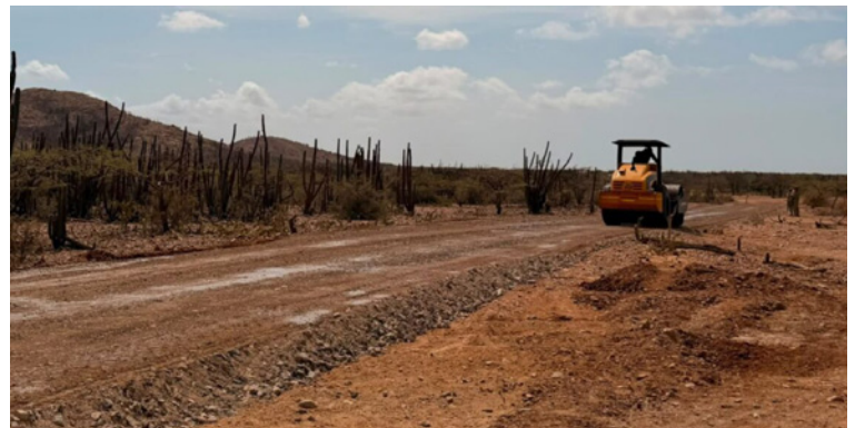
Indica el Ejército que estas obras contribuyen al mejoramiento de la infraestructura y al desarrollo de Uribia.
