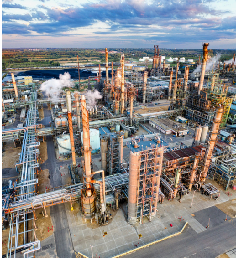
El gremio reiteró su disposición de trabajar con los actores del sector para proteger la infraestructura energética.
