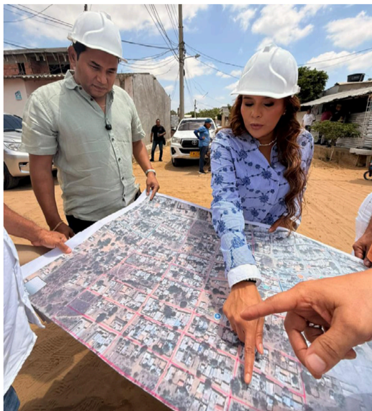
Andreina destacó el trabajo del equipo técnico y el impacto tangible que la obra ya genera en la comunidad.
