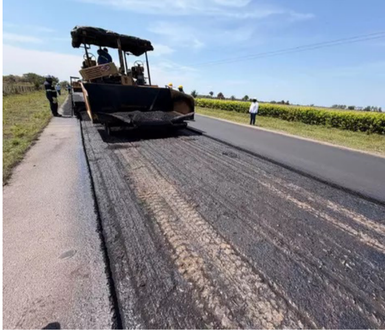
El Gobierno nacional reafirma su compromiso con el mantenimiento y la modernización de la red vial.
