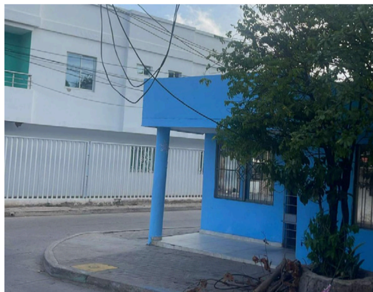
La comunidad insiste en que la presencia de cables energizados en el suelo constituye un riesgo grave.
