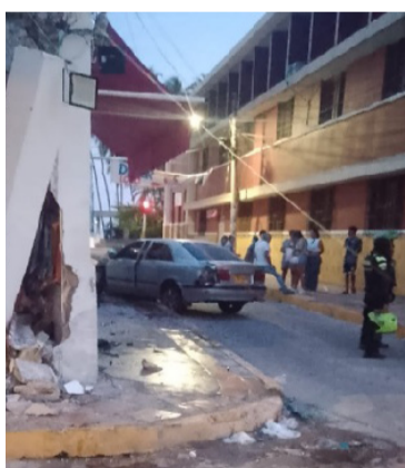
El local comercial quedó bastante averiado.
