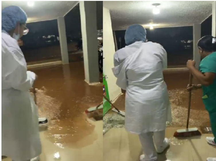
La temporada de lluvias vuelve a poner en evidencia la vulnerabilidad de muchas viviendas en Villanueva.
