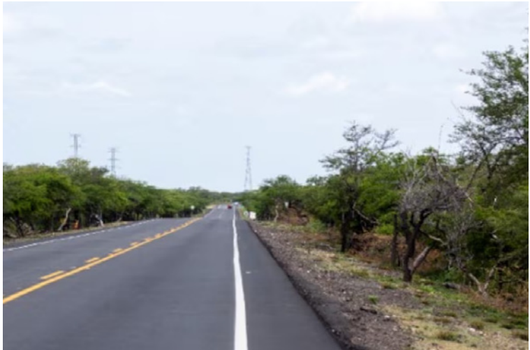
Se consolidó el cierre del proceso para la ejecución de obras e interventorías viales en 14 departamentos.
