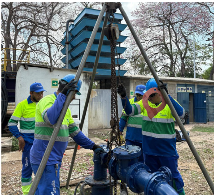
La presión y continuidad del servicio para los usuarios legalmente conectados se han visto afectadas.
