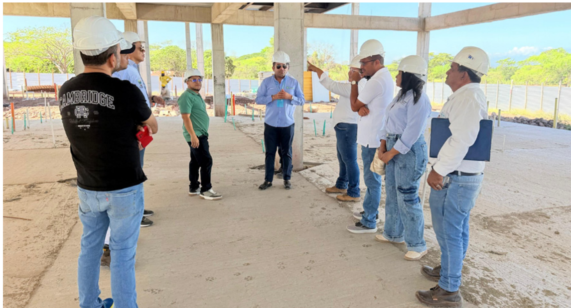
La culminación de la obra sería a mediados del mes de julio del presente año.
