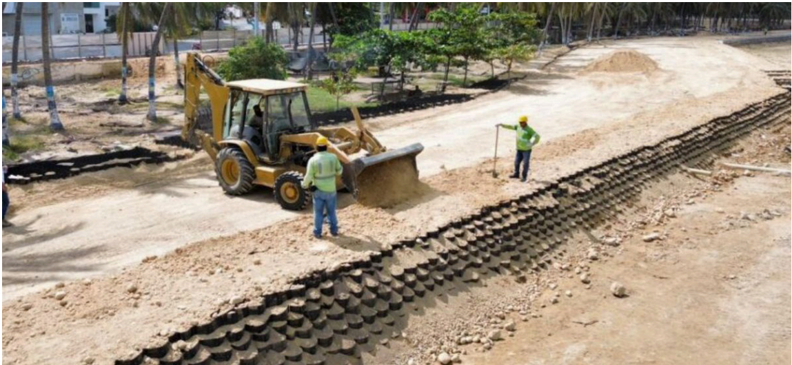
Una obra que se ejecuta en cinco zonas a lo largo del litoral de la capital guajira.
