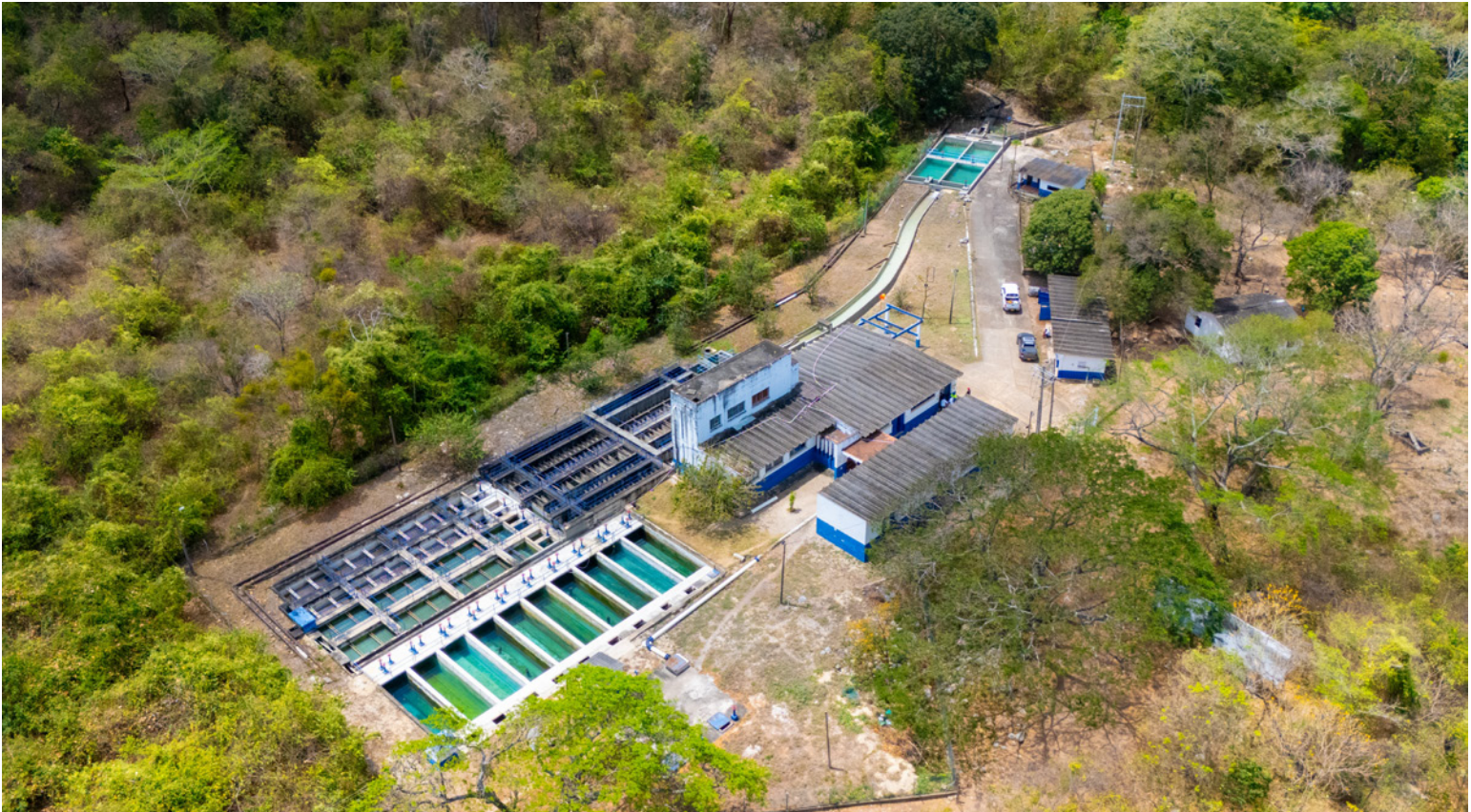
Planta de Tratamiento de Agua Potable - Ptap El Jordán – Maicao, La Guajira.
