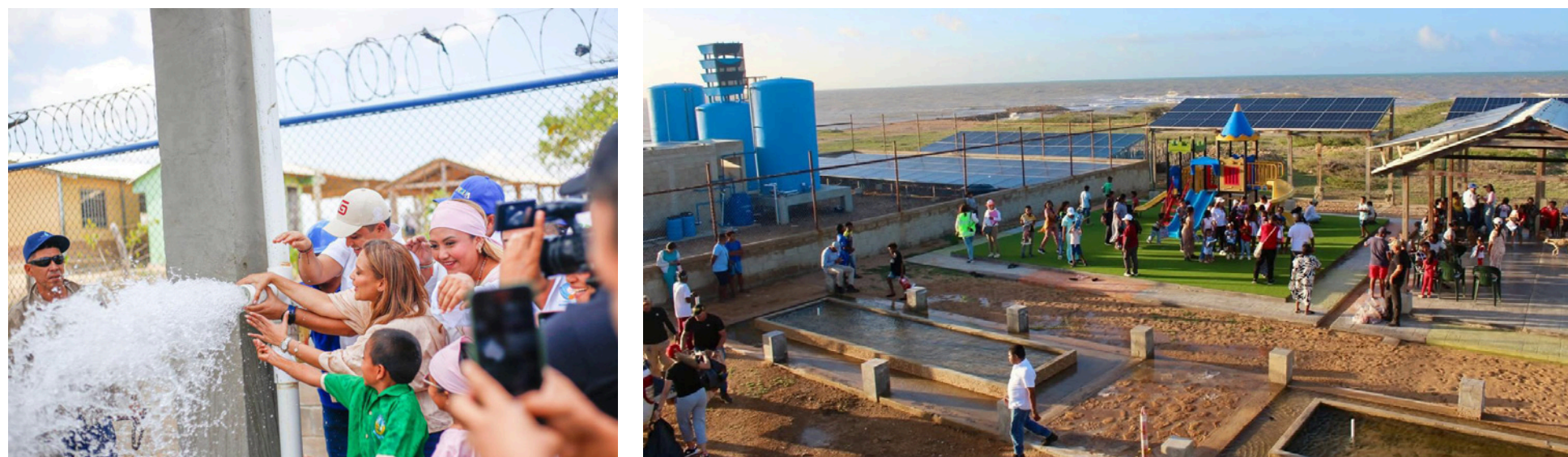
Inició la puesta en marcha de la planta desalinizadora de Puerto Estrella (Uribia), un paso clave para la Alta Guajira.
