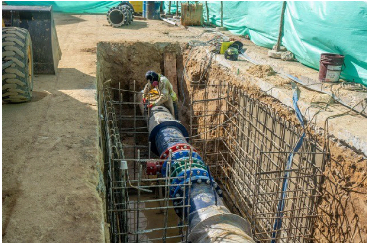
Los trabajos permitieron habilitar la vía, tras la finalización de las obras, el pasado 5 de diciembre.
