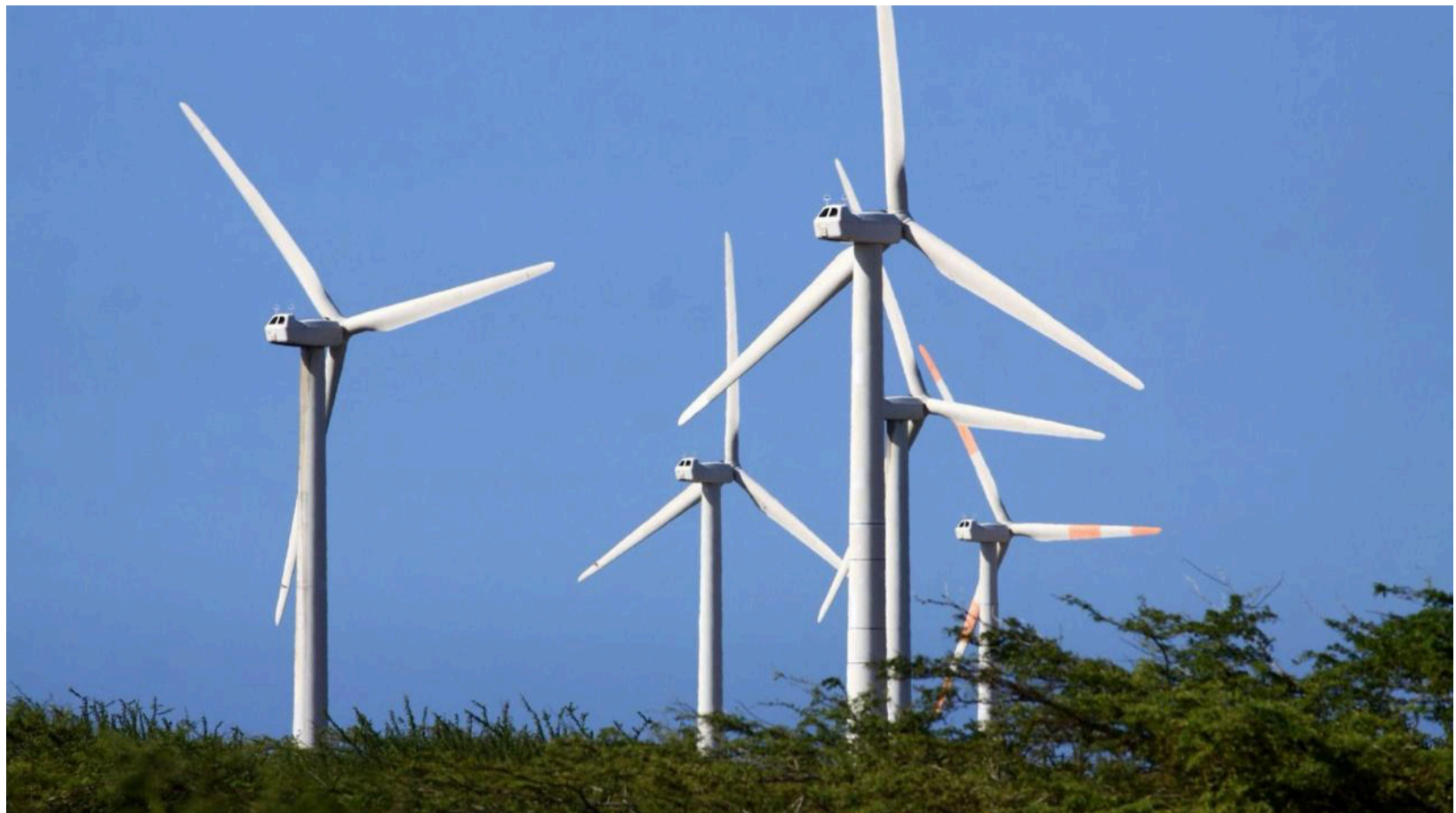
El Parque Eólico Camelias estará ubicado al norte de Colombia, en el departamento de La Guajira.
