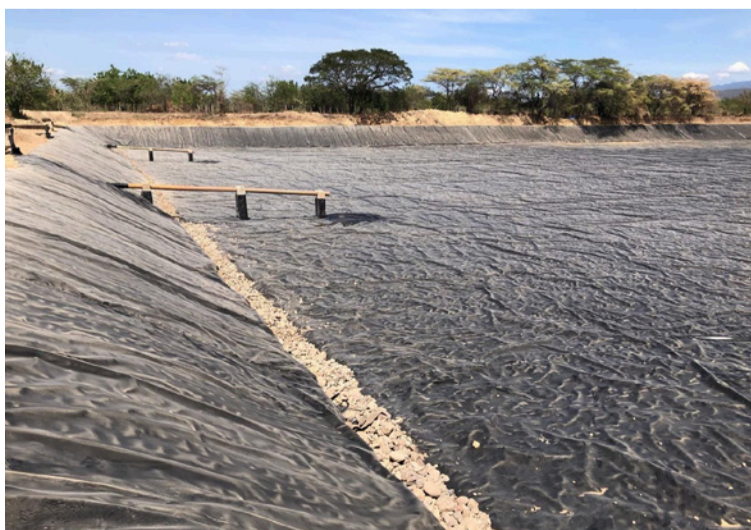
Optimización sistema de aguas residuales de Fonseca.
