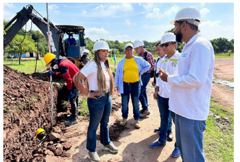
Las obras que se realizan del alcantarillado del municipio de villanueva.
