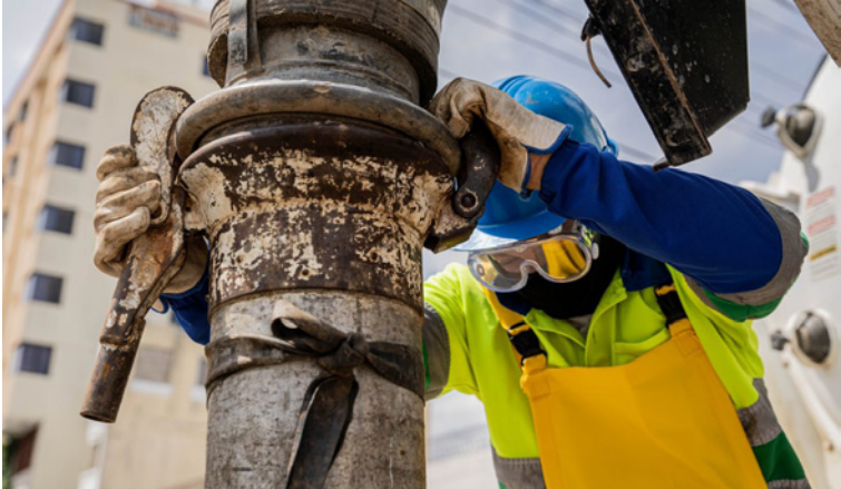
Se informó que avanzan en los trabajos que permitirán restablecer plenamente la operación del sistema.
