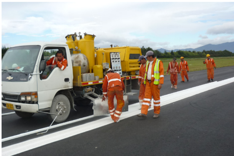
Pavimentos Colombia se estrenó en 1968 con la ampliación de la pista del Aeropuerto Militar de Apiay.
