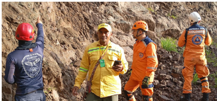
Una comisión de organismos de socorro detectó varios puntos críticos por deslizamientos de tierra.
