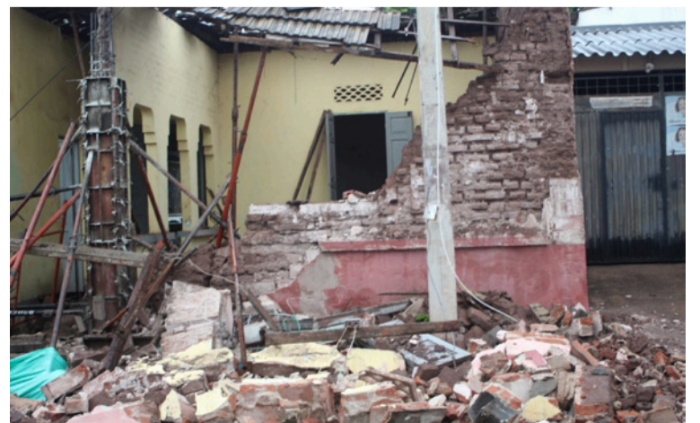
El colapso de la vivienda afectó el techo y la pared principal y generó momentos de angustia.
