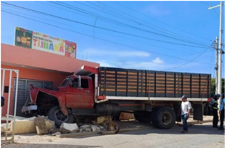
Debido al fuerte impacto, la fachada del inmueble sufrió daños como también el pesado vehículo.
