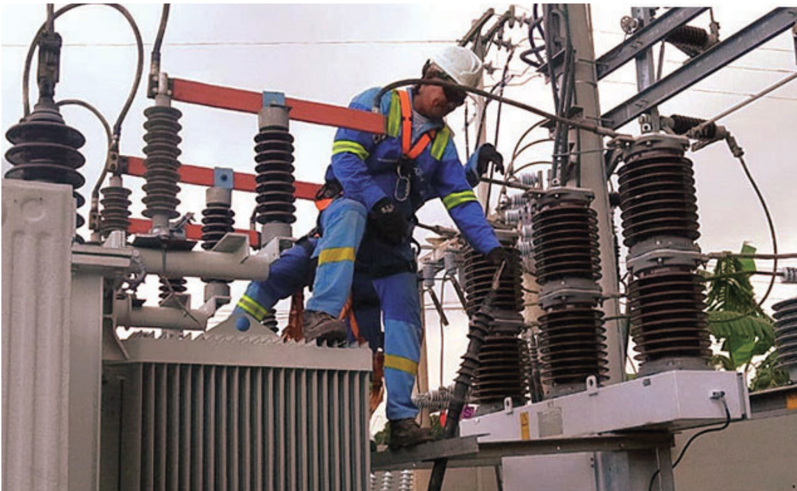
Se contempla en el mediano plazo la construcción de una subestación provisional.
