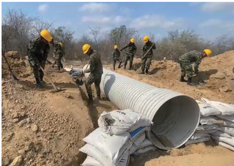
El Ejército Nacional ha construido tres obras de alcantarillado (dos en La Sabana y una en Panamá).
