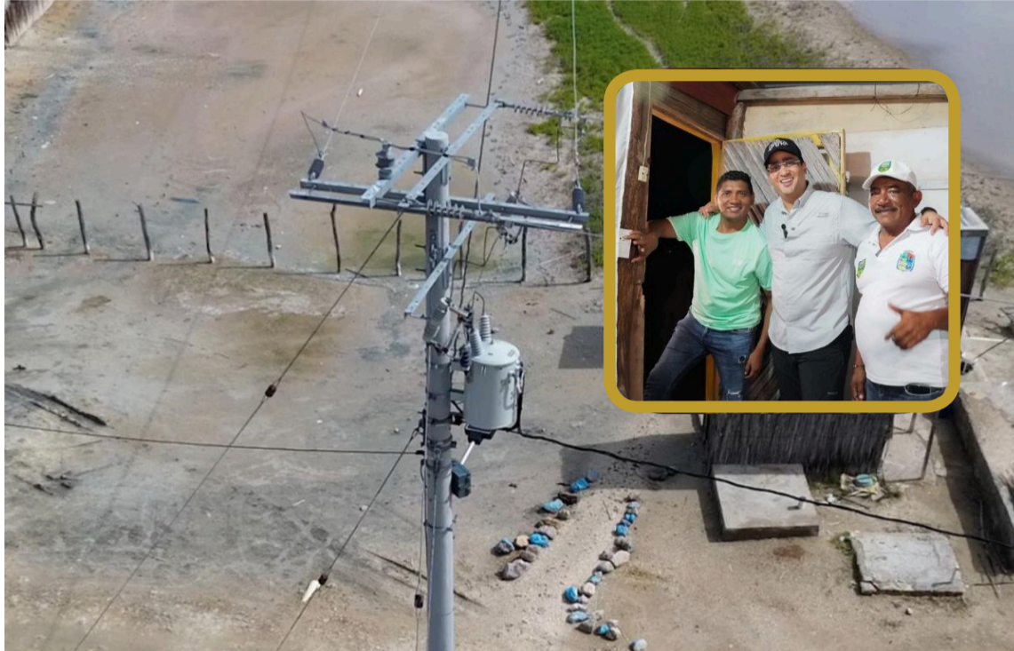
El proyecto contempló la instalación de 39 kms de nuevas redes de media tensión.
