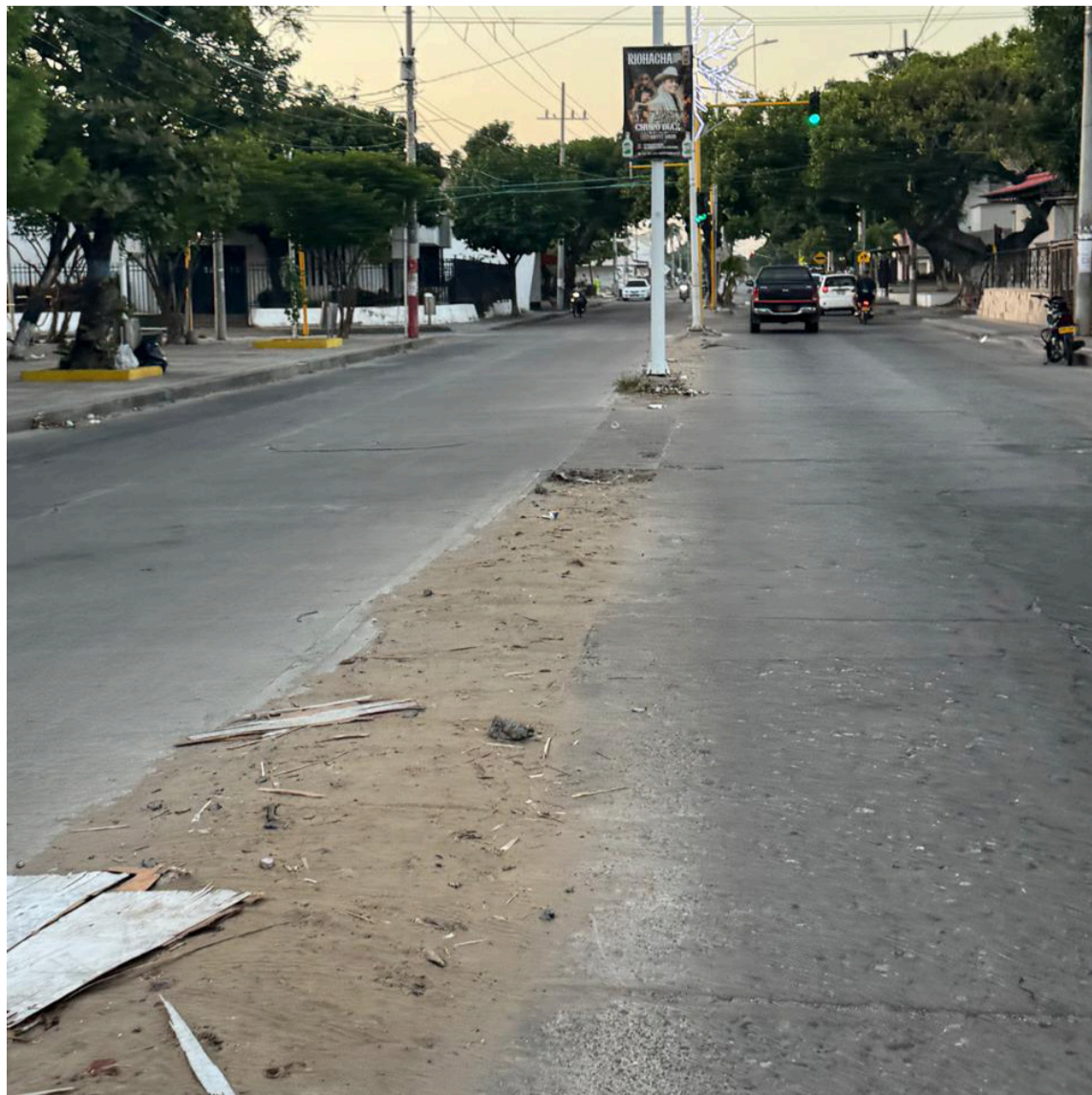
Queda pendiente la construcción de bordillos, reposición de árboles y las calzadas.
