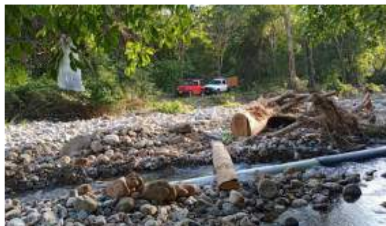
Las fuertes lluvias causaron una creciente que se llevó la tubería que suministra agua potable a toda la zona.
