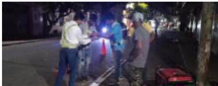
Se delimitan carriles y se establece señalización vial que permita una mejor organización del tráfico.
