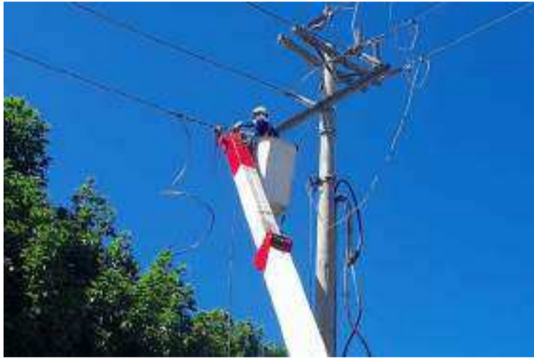
La falla fue causada por un cortocircuito en el cableado que conecta la subestación de San Juan con Villanueva.
