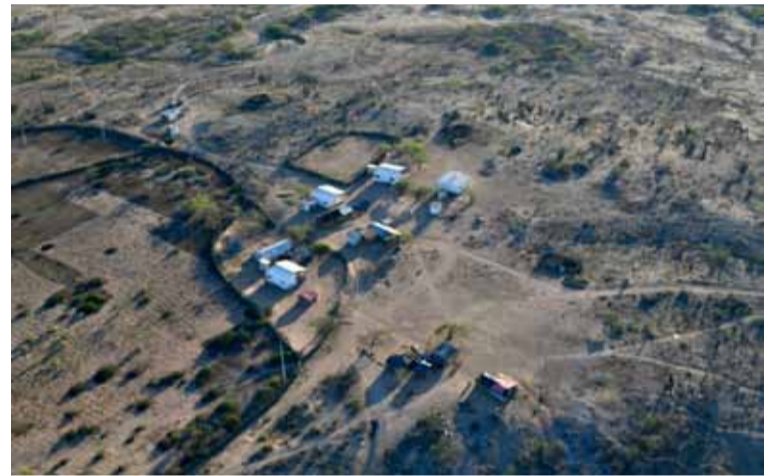
Tecnoaguas SAS, informó que la Ungrd no ha transferido aproximadamente 40.000 millones de pesos.
