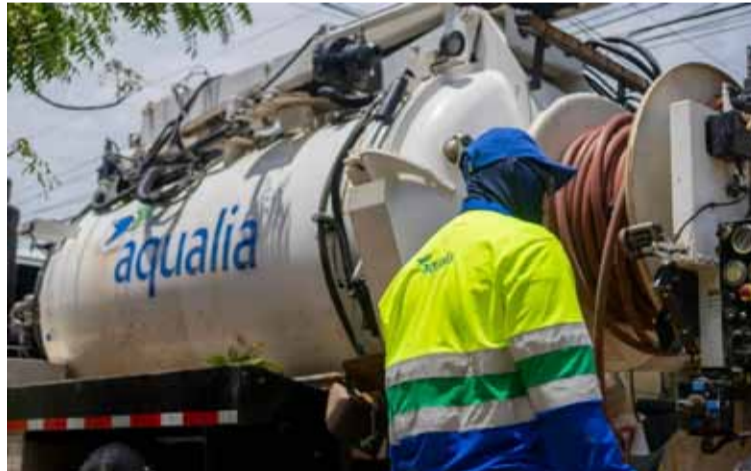
Olivella explicó, que con tecnología de punta colocarán unos dispositivos ultrasónicos dentro de la tubería.
