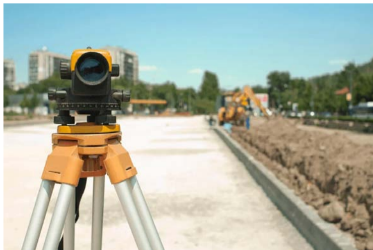
Con la invitación del gobernador Jairo Aguilar comenzarán a ver muchas obras con alta calidad.
