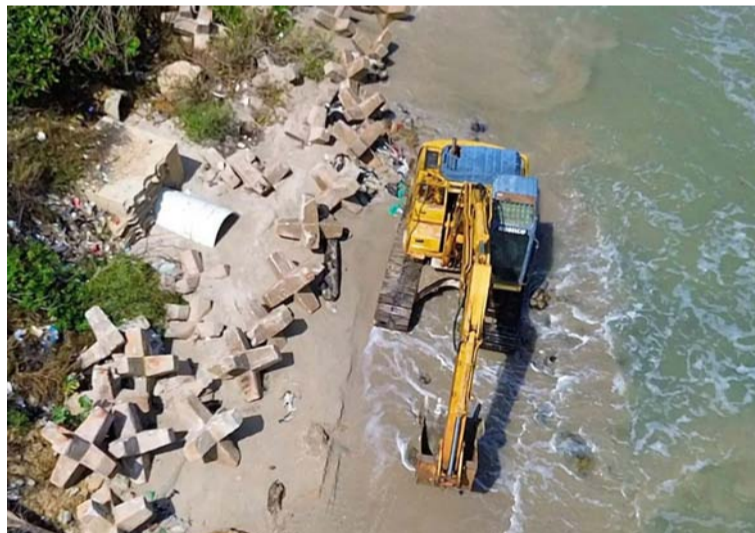
La intervención mitiga los efectos de la erosión costera y cuida de la vida de las personas que habitan la zona.
