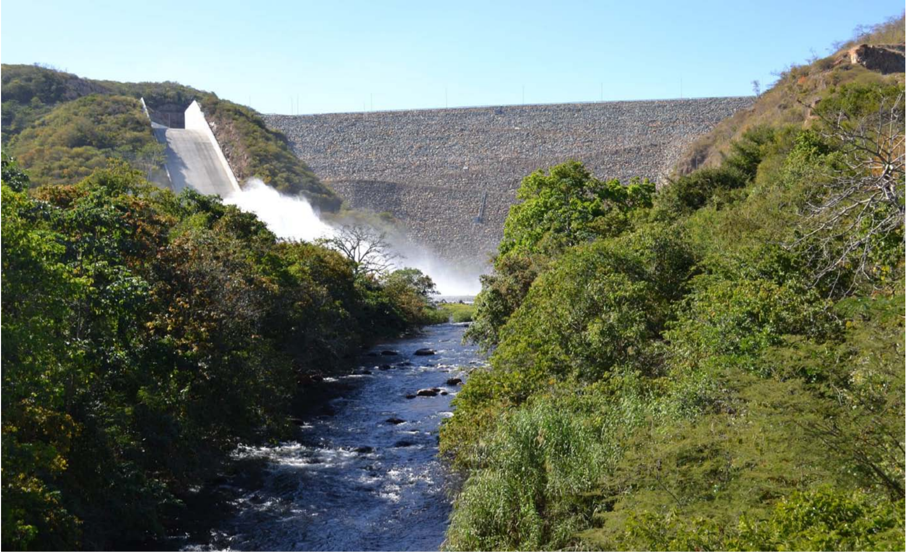
La represa del río Ranchería es de tipo enrocado, altura de 110m, área inundada de 638 hectáreas y capacidad de 198 millones de m 3 de agua.
