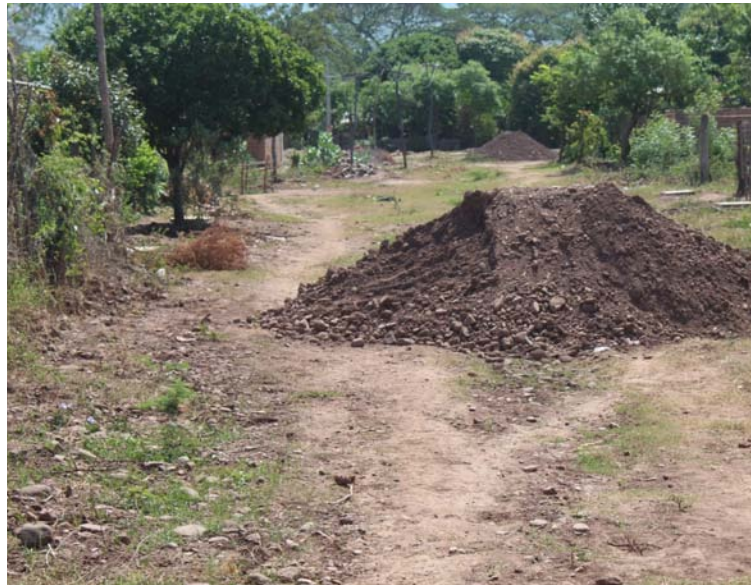
Se observan varias pilas de material de arrastre que en su momento fueron aplicadas para el respectivo relleno.
