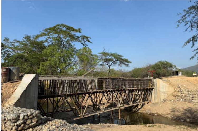
La estructura, de 23 metros de largo por 5.7 metros de ancho, proporcionará un enlace vital entre estas comunidades.
