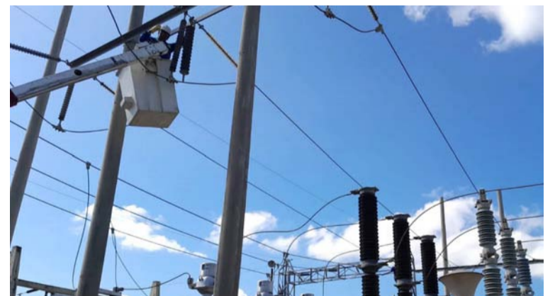
Los trabajos se harán en la línea 748 que interconecta las subestaciones Valledupar y San Juan del Cesar.
