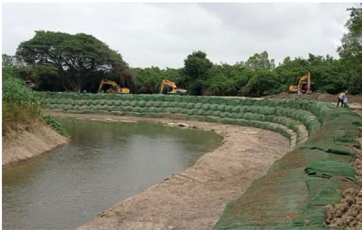
Los trabajos comprenden la construcción de obras de contención y dragado en el cauce del río Tapias.
