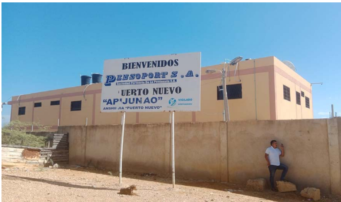
En Puerto Nuevo, jurisdicción de Uribia, se encuentra la Sociedad Portuaria de La Guajira, lugar en donde descargan la mercancía que abastece a Maicao.
