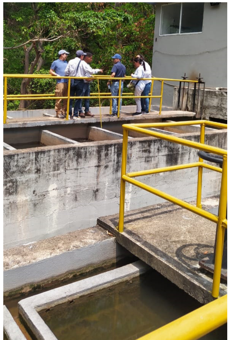
En próximos días se estará realizando la socialización y primera piedra de esta importante obra.
