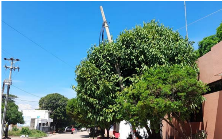
El poste está arrecostado y solo lo sostiene una rama de un árbol ubicado en ese sector de barrio San Luis.
