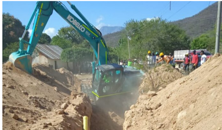
Eliécer Edilmer Daza Cuello ingresó a la zanja y sorprendentemente se le vino el alud de tierra encima.
